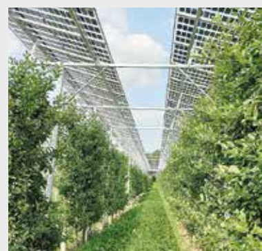
Hochgeständerte lichtdurchlässige Module für Dauerkulturen HAIDEGGER
